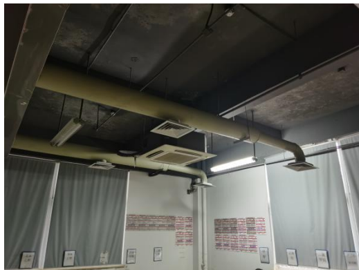
图3-4 溶剂室集气装置
