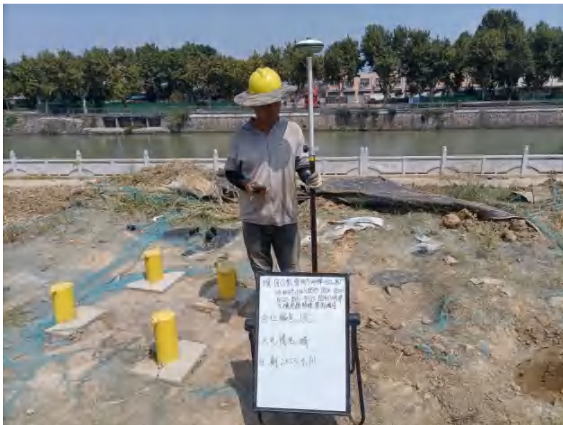
图 3-1 现场 RTK 放点
