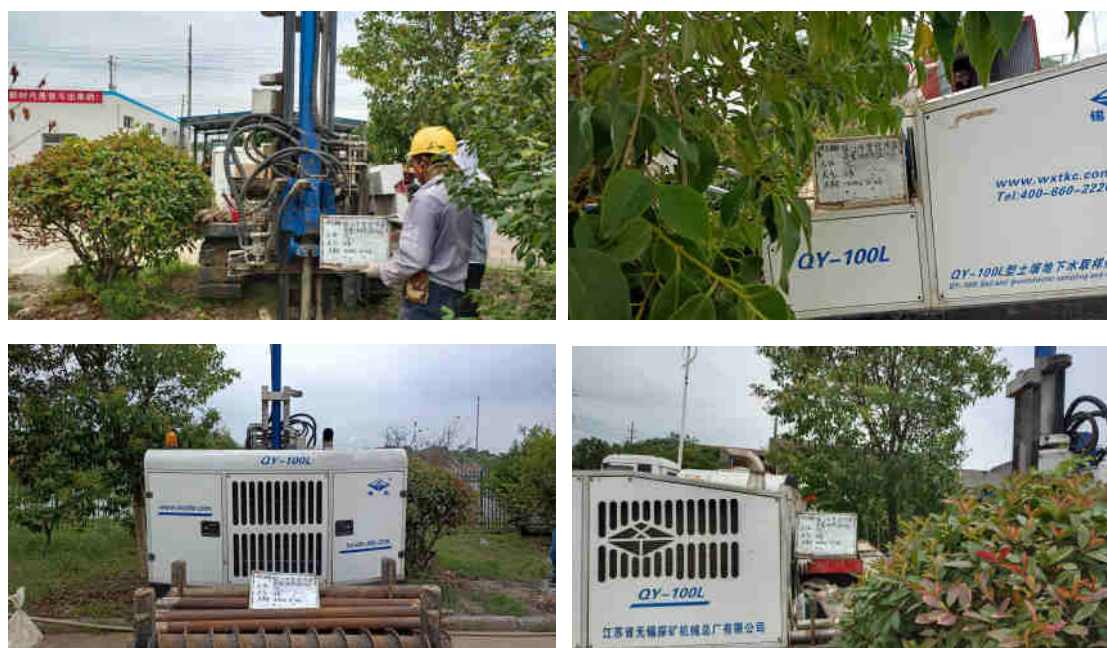
图 5.4-1 土壤钻孔过程
