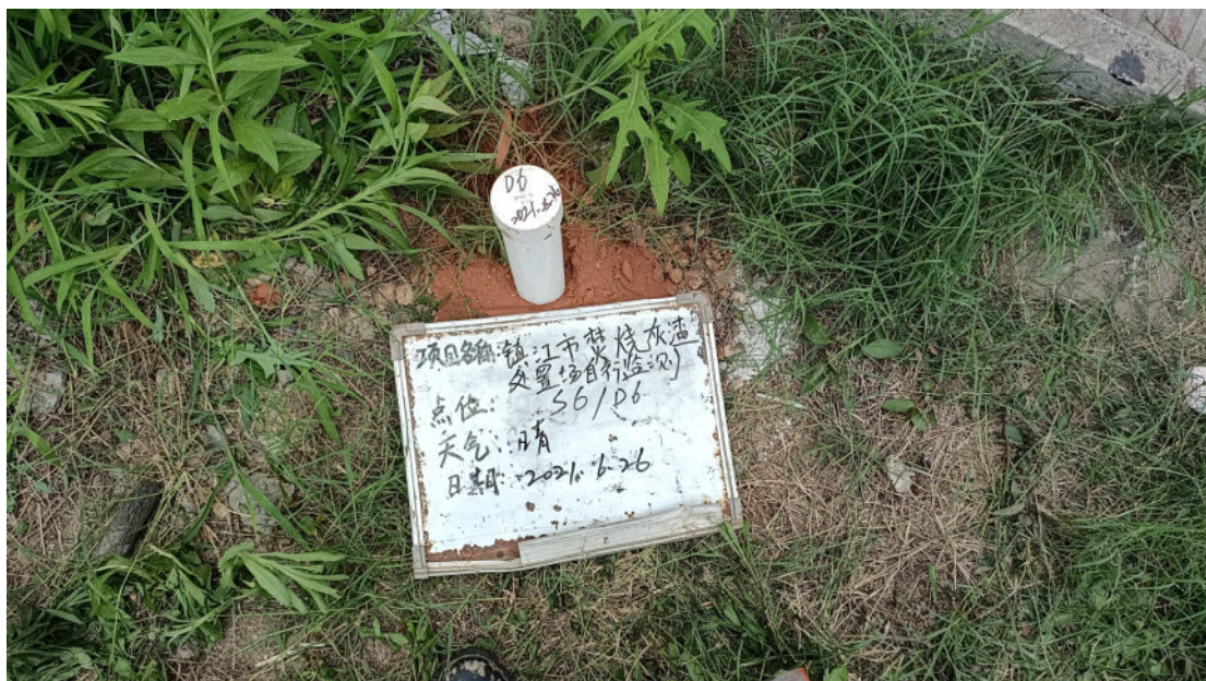
图 5.4-3 地下水监测井建设过程
