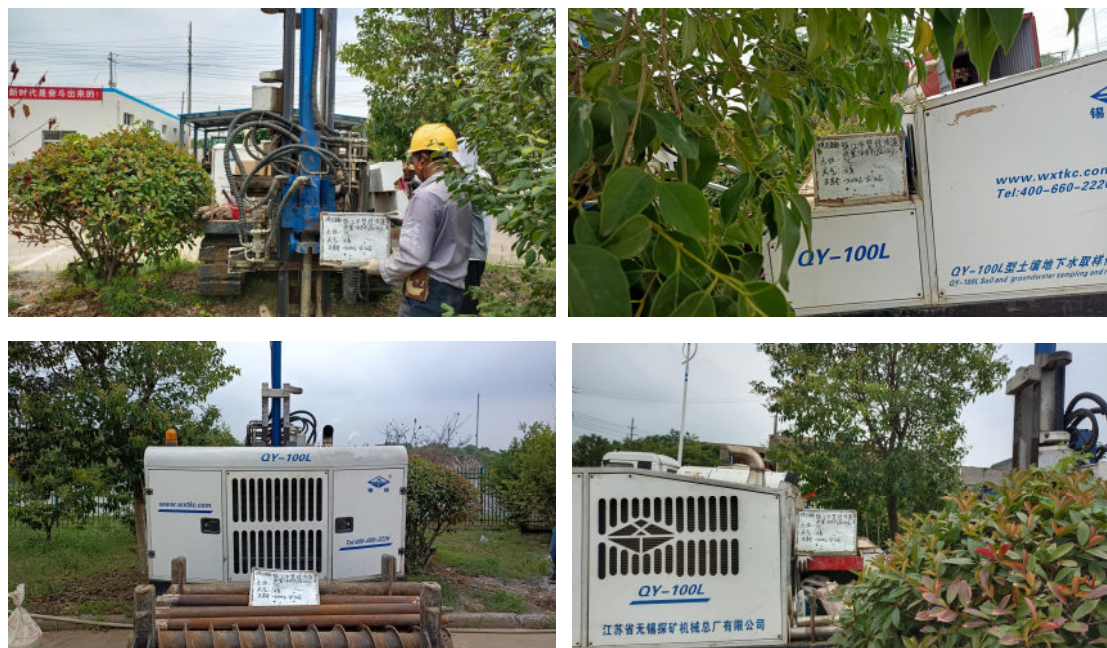
图 5.4-1 土壤钻孔过程
